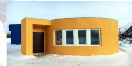
Первый дом в РФ, отпечатанный целиком, а не собранный из отпечатанных панелей.
